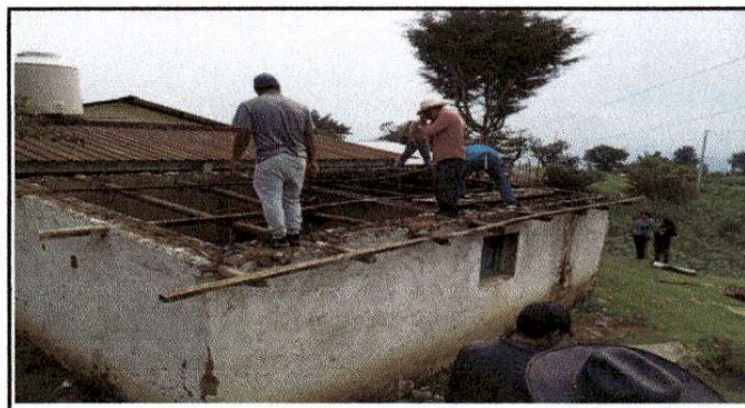
Foto 4: quitado de láminas deteriorados de cocina escolar
