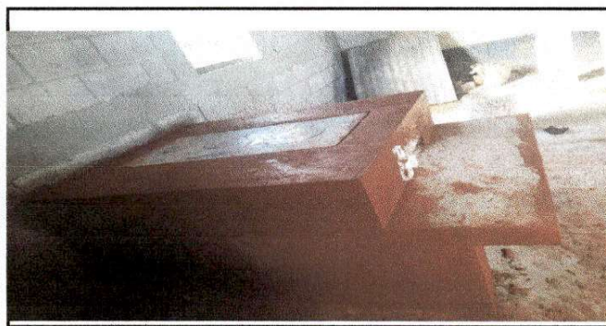
Foto 5: construcción de estufa rural
