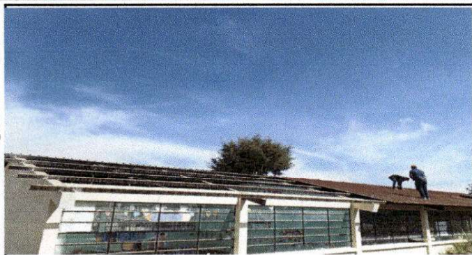
Foto1: sustitución de lámina
