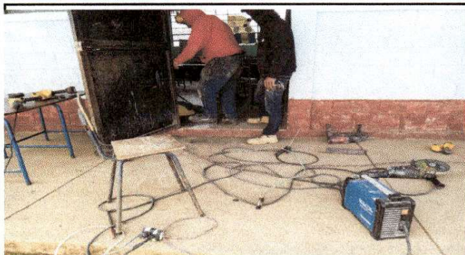
Foto 2: mantenimiento de puertas en modulo de aulas
