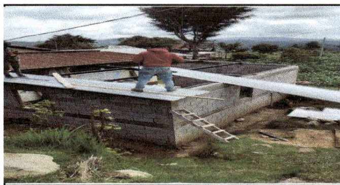
Foto 6: proceso en estuctura y entechado de cocina escolar
