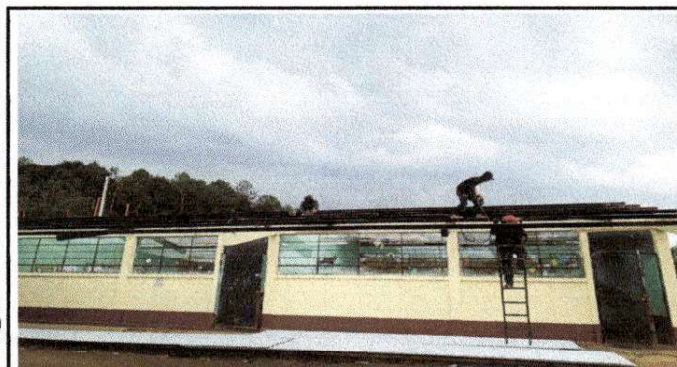
Foto 3: proceso en lijado, y pintado de estructura de techo de aulas
